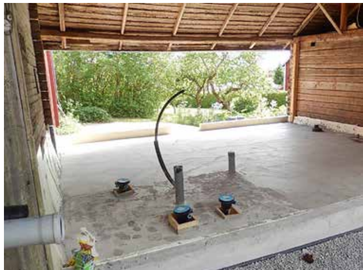
Golvet är gjutet i det som ska bli sommarkök med WC-utrymmen.
