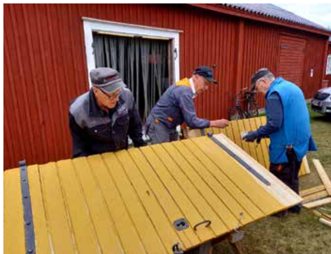
Man brukar vända blad, men vid båtmuseet har dörrarna vänts i sommar. Hela 5 dubbeldörrar på museiområdet har åtgärdats med brädbytten och med målning två gånger. Flitiga ”dörrvändare” har varit Ralf Söderback, Unto Risberg och Alef Holmlund som här fixar stockhusets dörrar.
