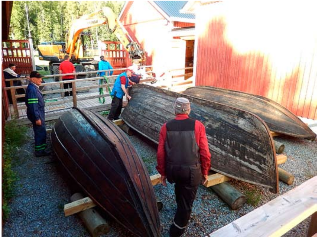
Fem båtar lyftes in med grävmaskin på krossgrusbädden mellan motorhallen och utställningshallarna.
