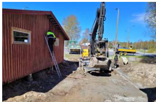
I mitten på maj inleddes en utbyggnad på 57 m 2 av båthallen. Entreprenör är Lindberg Construction Ab från Malax. – Foto: Gunnel Smulter
