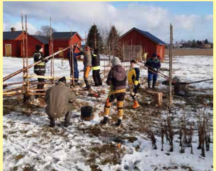
Bygget i full gång!
