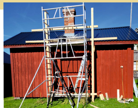
Sommaren 2025 har skorstenarna på snickarboden (bild) och Tufvasgården åtgärdats i samarbete med företaget Byggnadsvård Peltoniemi. – Foto: Gunnel Smulter.
