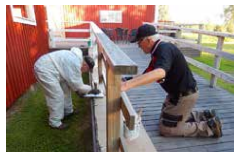
Den stora terrassen och bryggorna målades under sommaren. Här får räckena en första strykning med vit färg av Alef Holmlund och Ralf Söderback .
