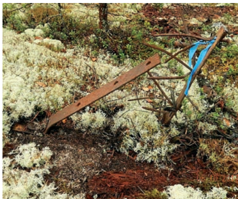
Tornplatsen. Den röda linjen visar var triangelpunkten finns. Tornet hade tre stödstoppar, som var fästade i berget med flatjärn. Bilden nedan visar ett av järnen med långa (hemsidda?) spikar. På marken syns gamla rester av tornet.
