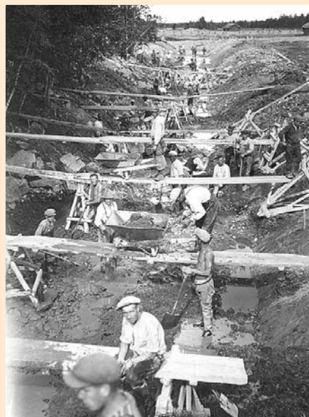
Bäcksgrävning i Malax i början av 1900-talet. Troligen är det Storsjöbäcken som istandsätts.
