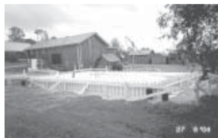
Arkivbyggnadens grund är nu klar! Det fina arbetet har utförts på entreprenad av David Björkell, som fortsätter jobbet nästa år (fönster och dörrar är redan beställda och erhållna). Svenska kulturfondens understöd har möjliggjort arbetet hittills. Vi hoppas att nästa år få byggnaden uppförd genom ett EU-projekt. En anhållan har på nytt riktats till Svenska kulturfonden för arkivets kommande inredning. Grunden är gjuten - ett behövligt arkiv är på kommande, förr eller senare!
