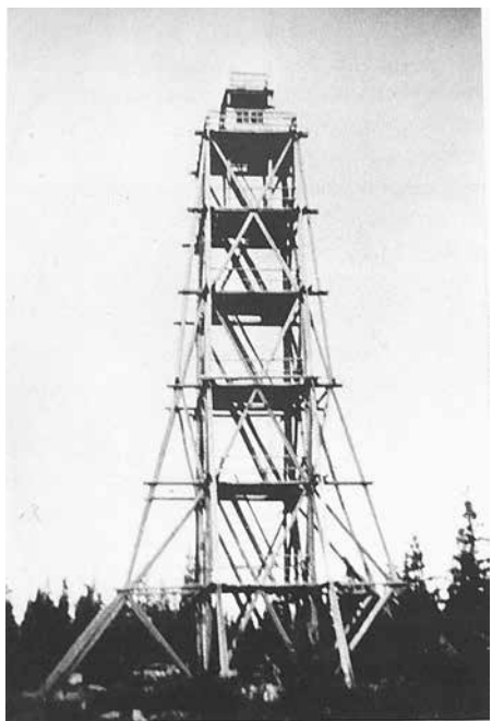
Rysstorn på Bergö Ryska utkikstornet på Granöskatan byggt i början av 1900-talet. Höjden kan ha varit 18–20 meter. Tornet föll omkull i en storm 1931. Bergö HembygdsMuseums arkiv. Bild och text ur boken Från Wargö till Bergö , utgiven av Bergö hembygdsforskare 2015.
