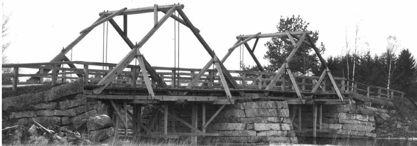
Också lokalhistoria: "Stobro" i Köpingsgränden under reparation ca 1950. – Ture Sandströms bild
