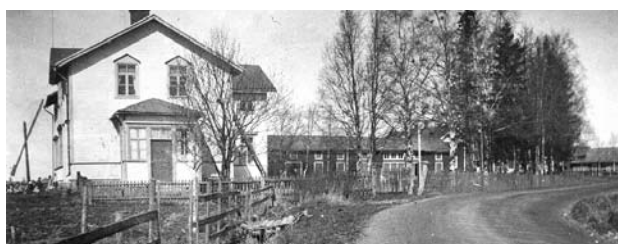
14 oktober 1955 beslöt kommunfullmäktige att kommunen övertar ett 20-tal bya- och ägövägar efter att dessa dels ombyggs och dels förbättrats. – Vägen förr vid Vias skola. Foto Torsten Lindgård.
