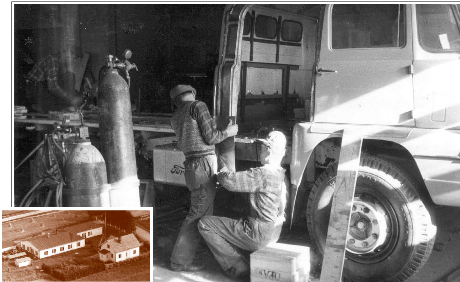
På Haléns cykel och karosseri byggdes karosser för alla slag av bilar. Här förlängs hytten på en lastbil, så att en grupp arbetare skall kunna åka i samma bil. Det var ofta el- och telefonbolag som hade behov av dylika ”kombinerare”. Förlängningen byggdes i plåt och omkring 1960 var det fortfarande gassvetsning som gällde. De skickliga hantverkarna är Evert Blomster och Stig Hallbäck. – Foto Georg Brokvist, Malax museiförening; skanning 2015 från Stig Hallbäcks bild.
