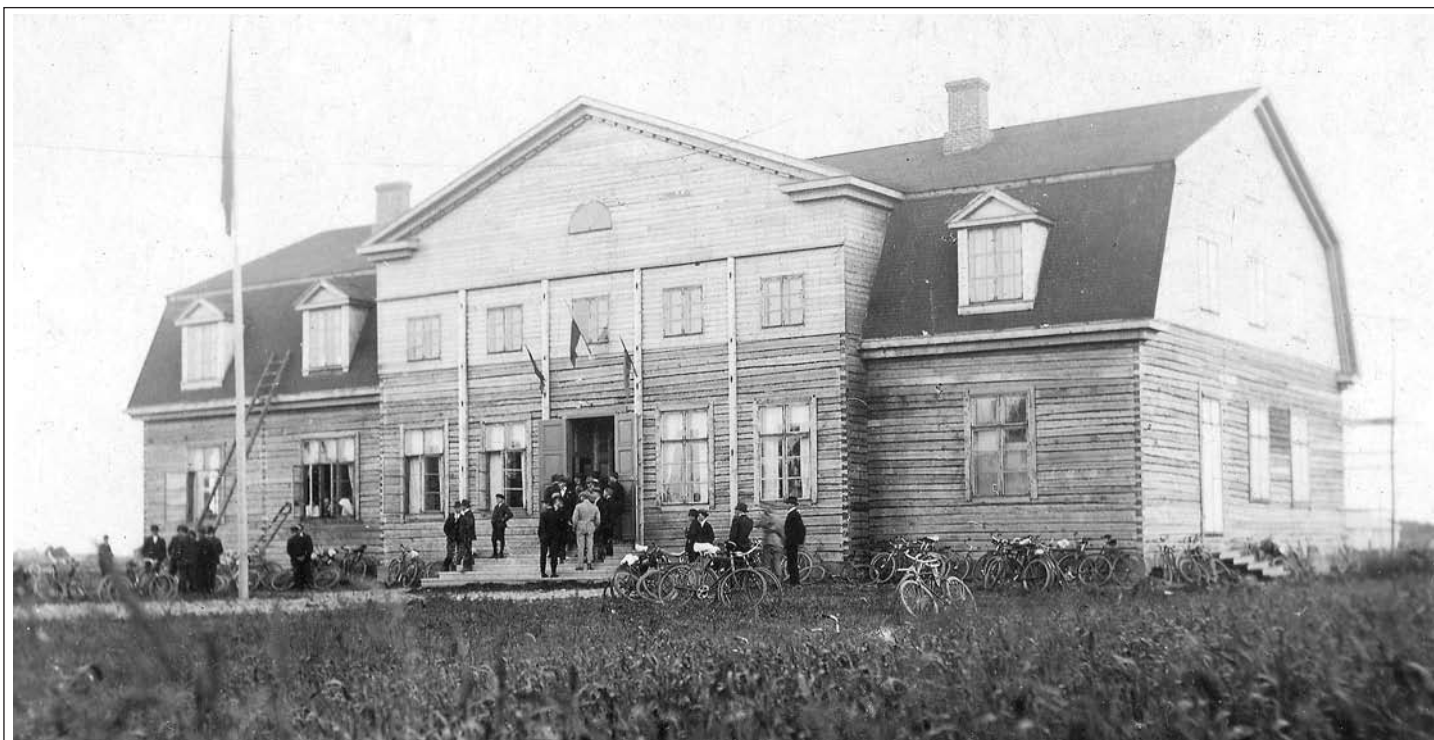
Bygdegården i Köpingsgränden. Malax ungdomsförenings samlingshus Bygdegården invigdes 1922, då det ännu inte var helt färdigbyggt. Ritningarna har uppgjorts av Bröderna Udds byggnadskontor i Helsingfors. Byggnaden ovan är Malax uf:s andra föreningshus. Det första byggdes 1897 och stod på andra sidan vägen mitt emot nuvarande hus. Stockarna från det gamla huset är väggar i nuvarande Bygdegårdens festsal. Som känt grundades Malax uf redan år 1888. – Foto O.E.Lång. Malax museiförening; skanning 2011 från Gerda Liljeroos bildsamling i museiföreningens ägo.
