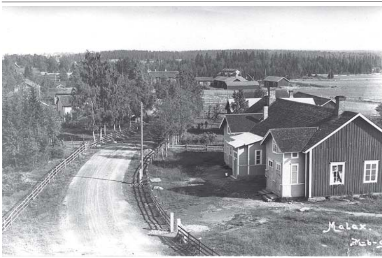
Sockenstugan på kyrkbacken (byggd 1830, tillbyggd 1922) och Mattlarsgårdarna Fotograf Ida Malmberg
