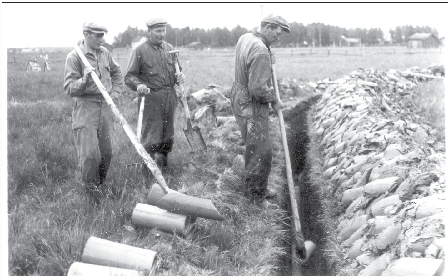
Täckdikning. I mitten av 1950-talet genomfördes ett täckdikningsprojekt från Molapnevägen ner till Heljobro (Helgeåbro). Smala diken grävdes för hand och med häst och kärra kördes rör och finsand ut på åkrarna. På bilden håller Elis Blomback, Artur Svedström och Elis Erkus på med det precisionskrävande arbetet att lägga ner rören. Informatör Margareta Bonn. – Foto: Holger Gullholm. Malax museiförening; skannad för Aanacko 2022 från Margareta Bonns bild.
