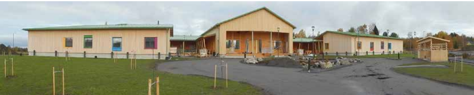
Malax i förändring. Det nya serviceboendet (från söder) intill Strandvägen i Yttermalax under uppförande i oktober 2019. Byggnaden blir inflyttningsklar 2020. (GS)
